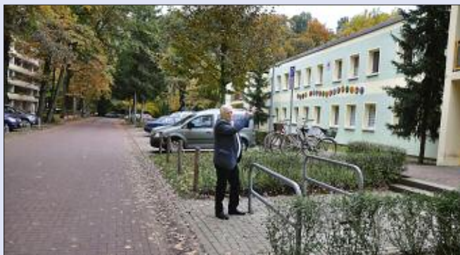
■ Die Kita Knirpsenhausen wird durch eine weitere Etage erweitert.
